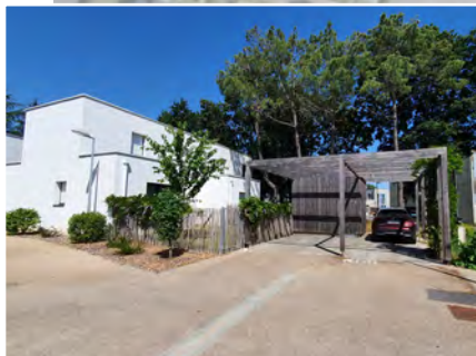
SAINT-MARC (44) HABITAT INDIVIDUEL + STATIONNEMENT DEPORTÉ RÉALISATION : IN SITU + ZEPHYR
