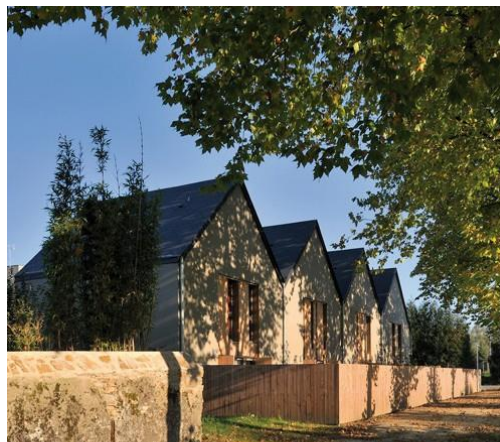
bouvron(44) reVitalisation cœur de bourg habitat mixte réalisation : garo-boixel
